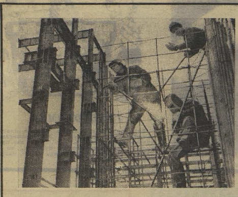
Ударная комсомольская стройка — атомная электростанция в Билибине скоро даст ток Чукотке.
